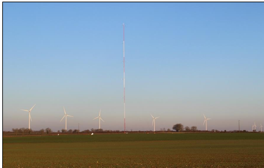
Figure 7 : Mât de mesures anémométriques du projet de la Plaine de Balusson (Crédit photo : EOLISE, janvier 2020)
